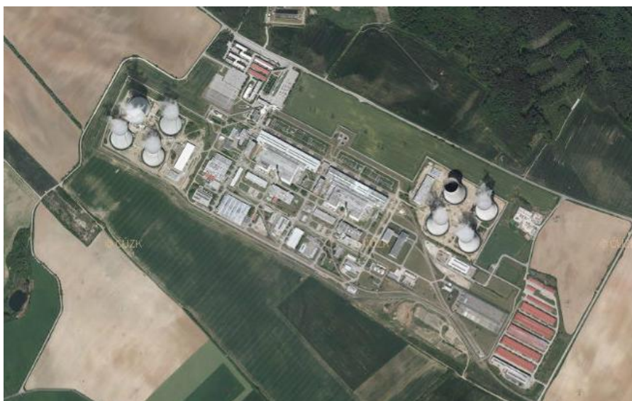
Jaderná elektrárna Dukovany
