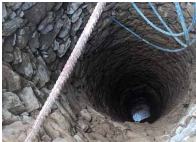
Oprava studny u dnes Novákových naproti obchodu.
