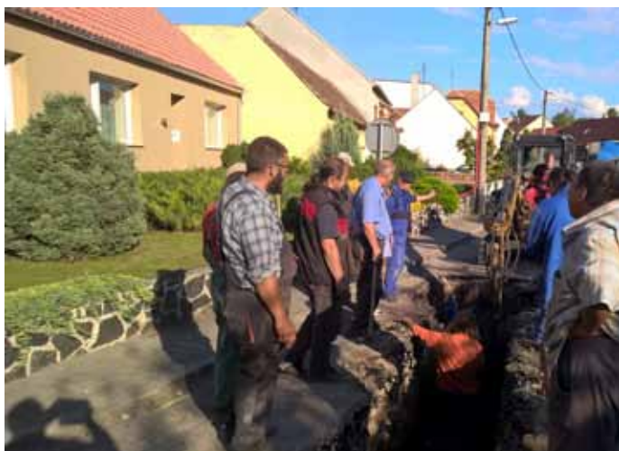
Rekonstrukce inženýrských sítí.
